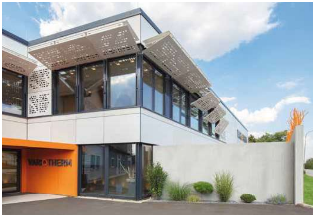
Prägend: Die Vordach-Flügel-Fassadenelemente verhindern Überhitzung
