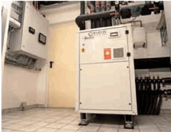
Die zweistufige Wärmepumpe von Rhoss ist der Kern der Heiz- und Kühlanlage.
